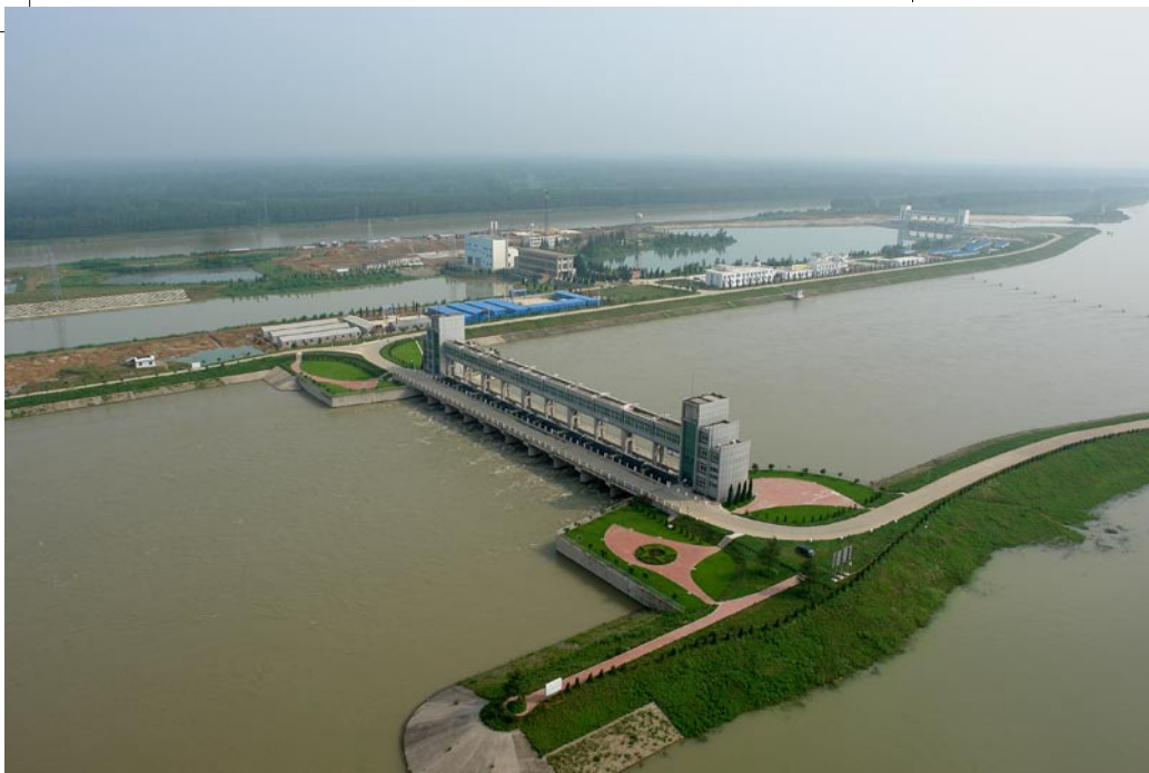
淮河入海水道二河枢纽工程（缪宜江 摄）
