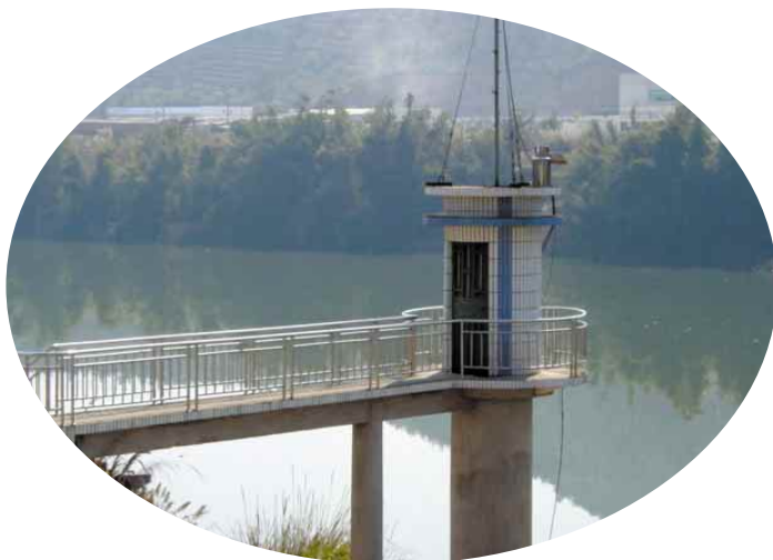
大樟溪永泰水位自记井
