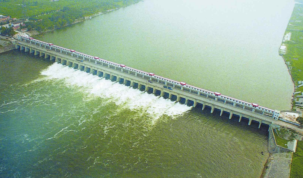
骆马湖嶂山闸枢纽（孟宪玉 摄）
