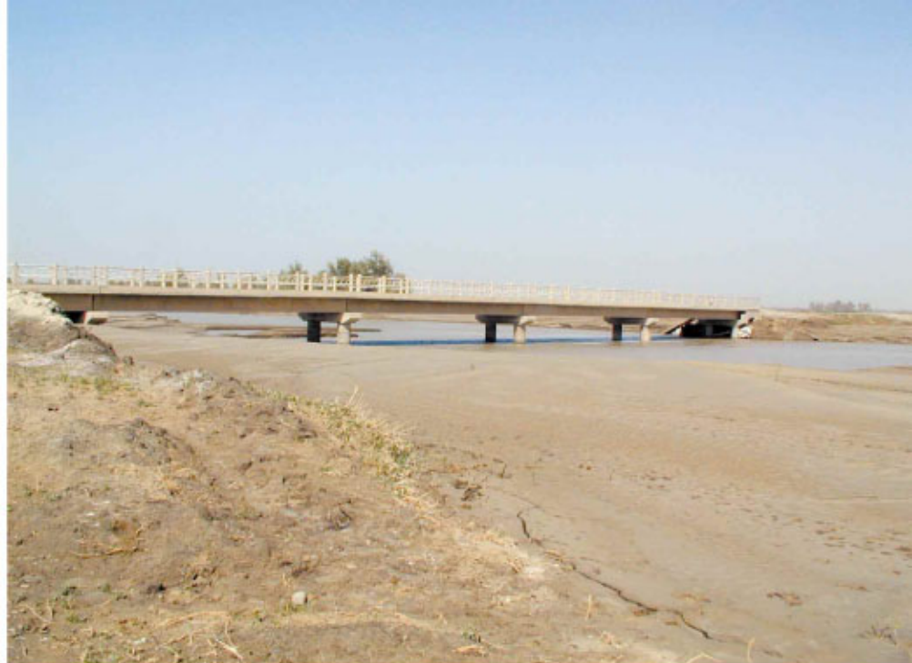
塔里木河喀尔曲尕大桥
