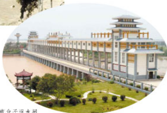
曹台子退水闸
