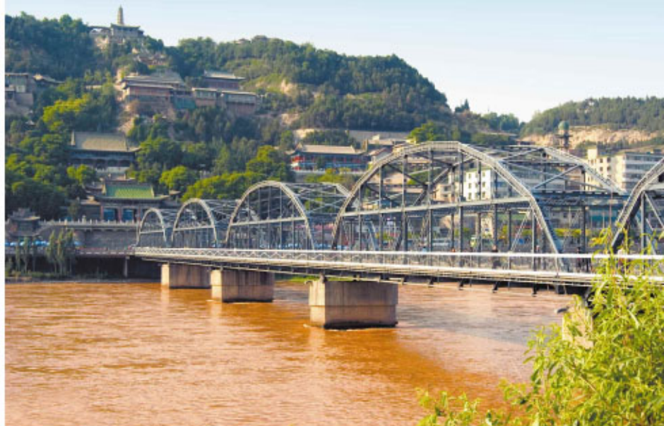
黄河第一桥（兰州铁桥）
